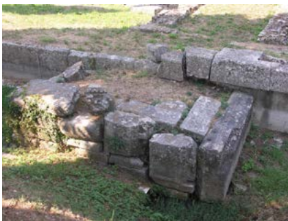
Abb. 12: Spätantike Stadtmauer von Aquileia, errichtet unter Wiederverwendung zahlreicher älterer Bauteile, sog. „Spolien“. (Foto: © Christian Witschel)
